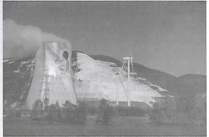
AKW Cruas, Frankreich
