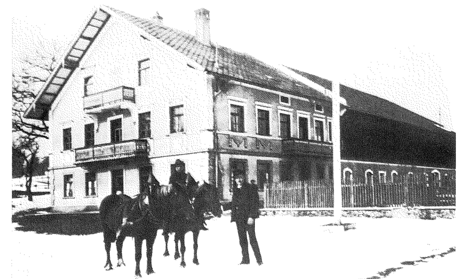
Der Schallnkamer Hof vor der Bajuwarisierung: Eisenbalkon, kleiner Dachvorsprung und keine Fensterläden
